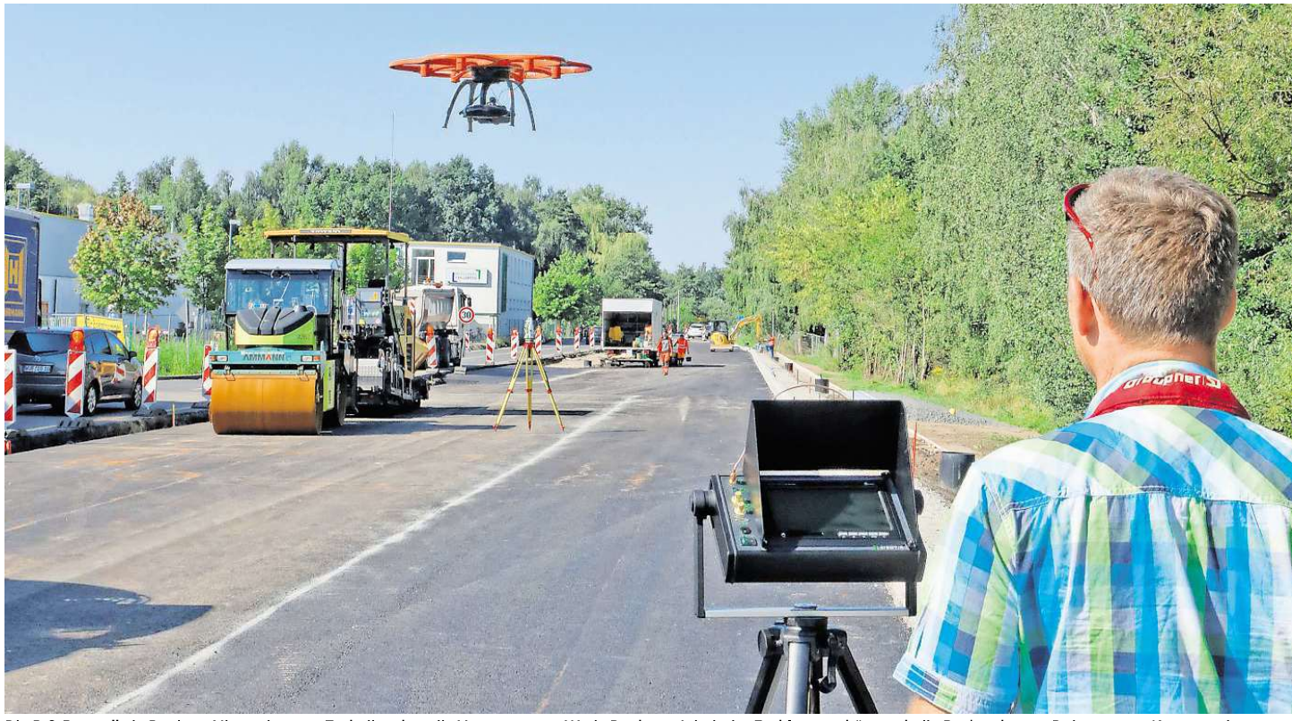
Die B 6-Baustelle in Deuben: Mit modernster Technik gehen die Vermesser ans Werk. Doch zur Arbeit der Fachleute gehört auch die Recherche von Dokumenten, Karten und Urkunden, die bis ins Jahr 1840 zurückreichen.
